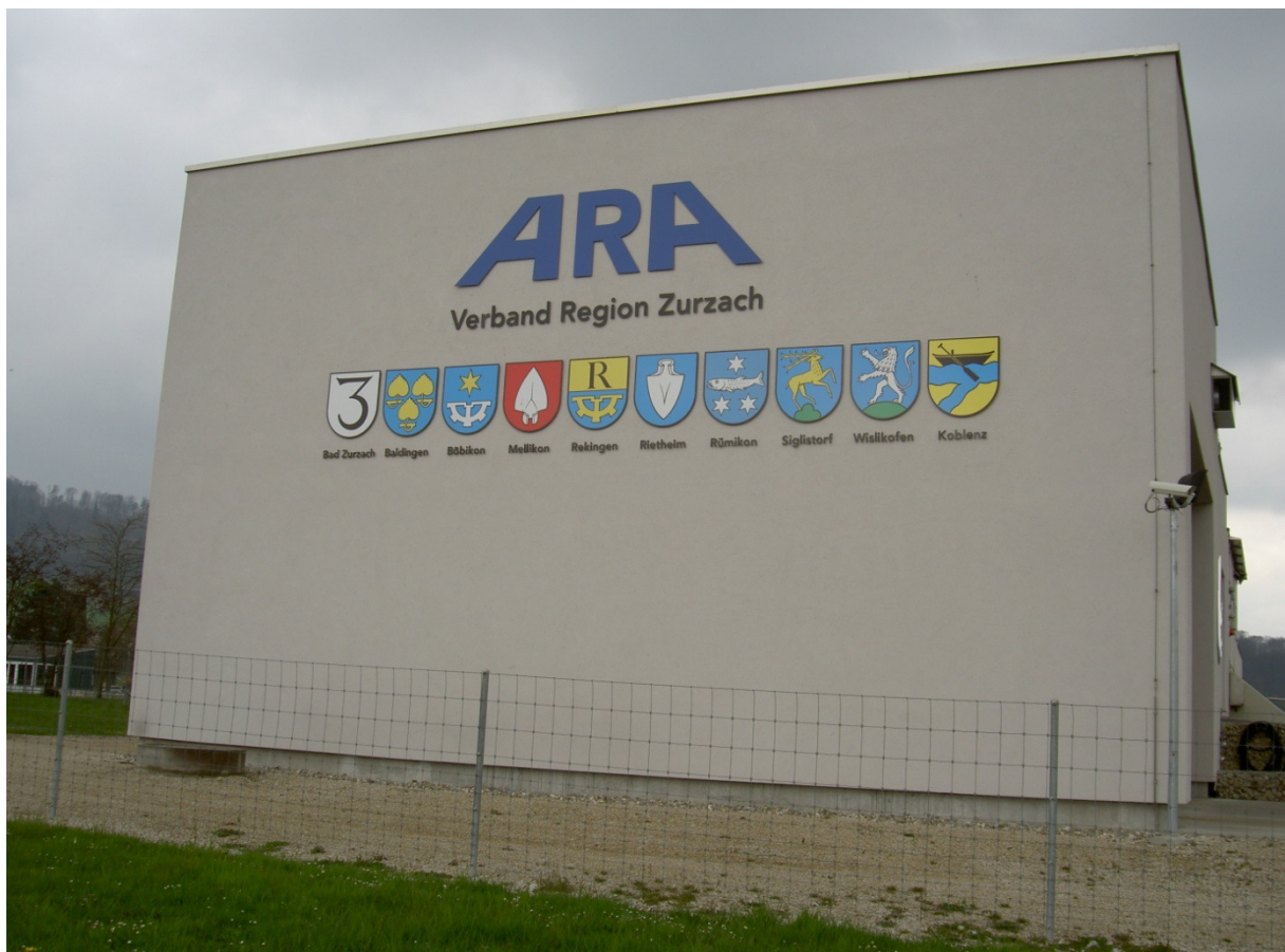
Gemeindewappen des ARA-Verbands Region Zurzach auf dem Schlammwässerungsgebäude
