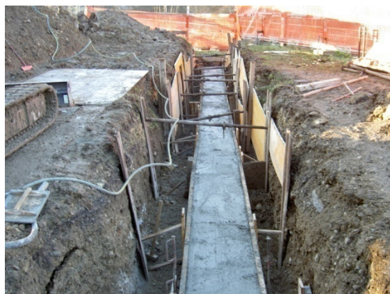
Abb. 8: Graben für Rohrverlegung
