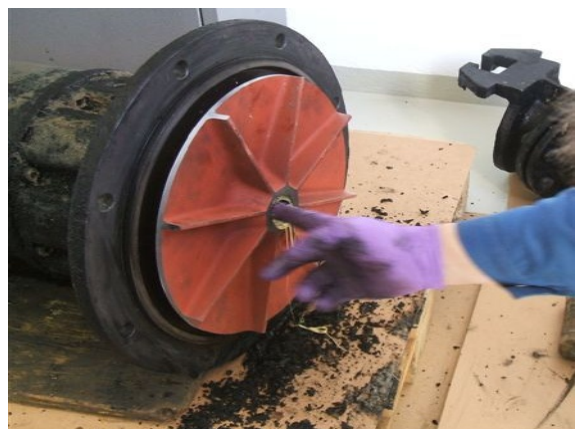
Abb. 8: neues Laufrad der Pumpe
